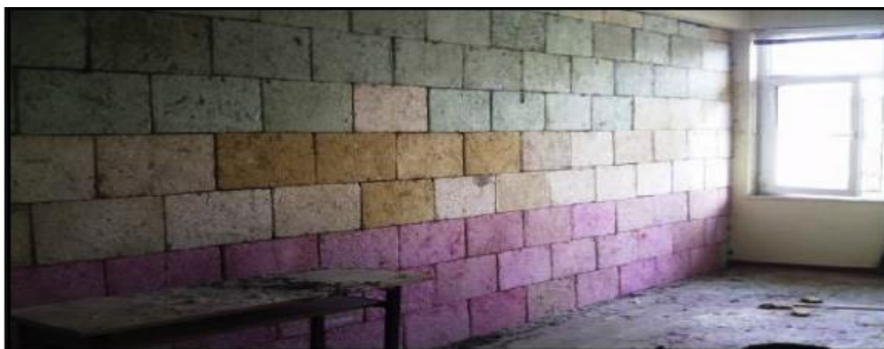
Figura 7 Utilizarea panourilor fonoabsorbante
